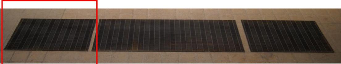
**Sección para carga puntual sobre 1300 mm de separación de apoyos.**
