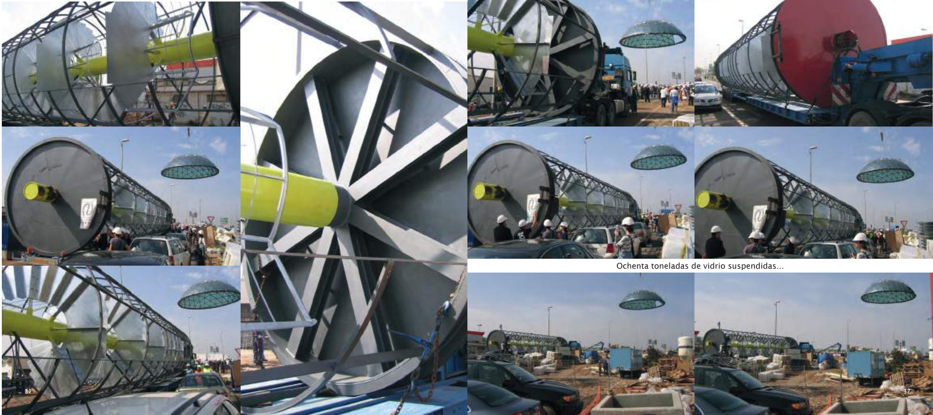
La llegada del cilindro exterior, en una única pieza, se produce en el momento del izado de la cúpula de cristal.
