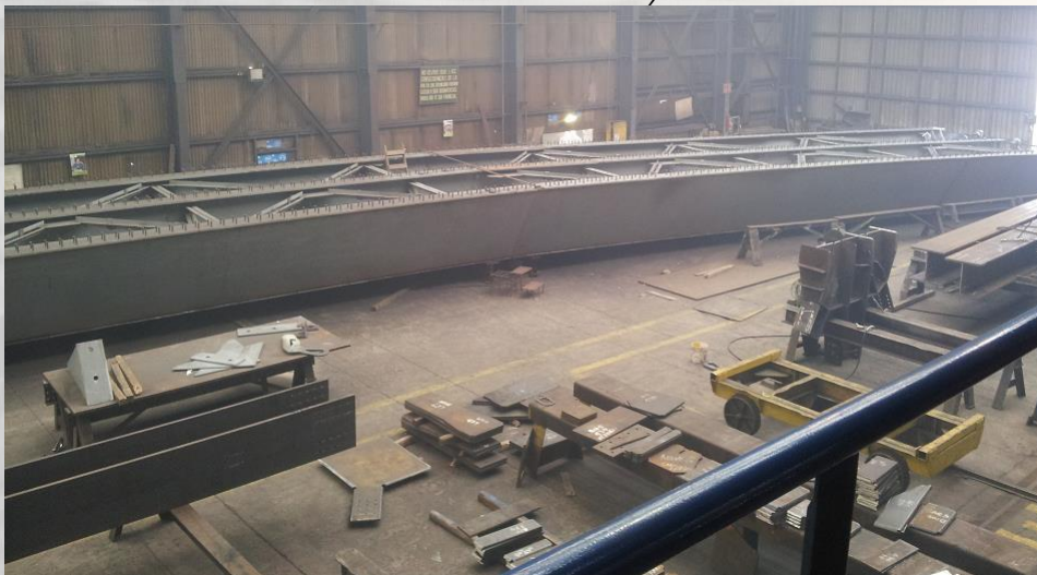
Puente Acceso Aeropuerto Araucanía – Freire, IX Región
