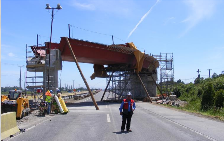
Puente Acceso Aeropuerto Araucanía – Freire, IX Región
