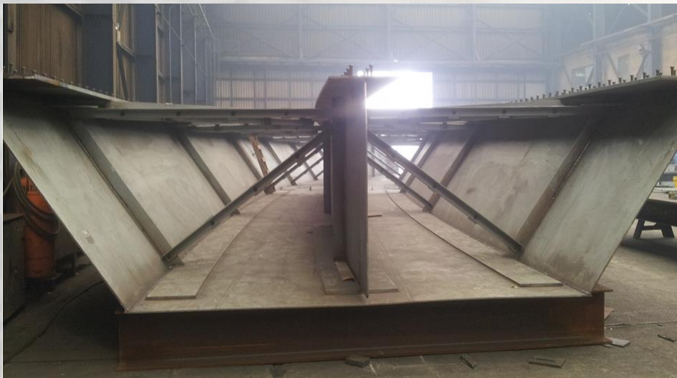
Puente Acceso Aeropuerto Araucanía – Freire, IX Región
